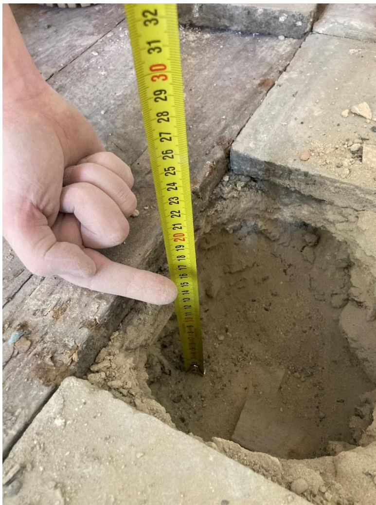
Obr.12: Sonda do podlahové konstrukce v 5.NP, Byt č.2
